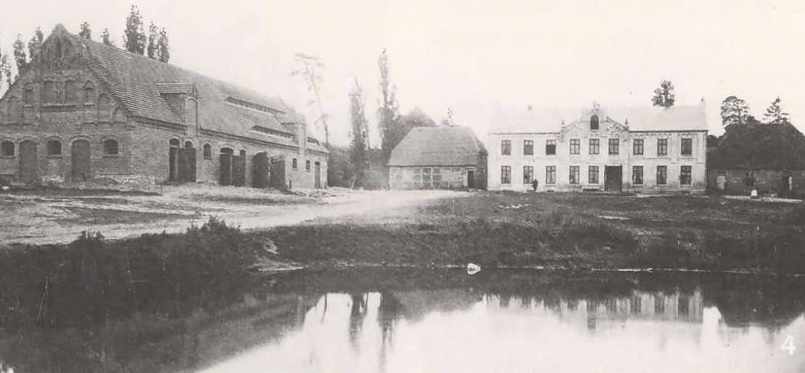
Das alte Gutshaus in Lüchow (ca. 1860)
